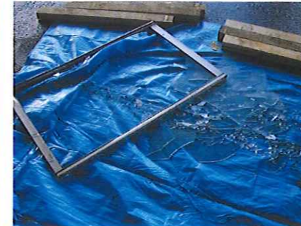
SC-74H施工無しの窓ガラス 割れたガラスは無惨に飛び散りました。
