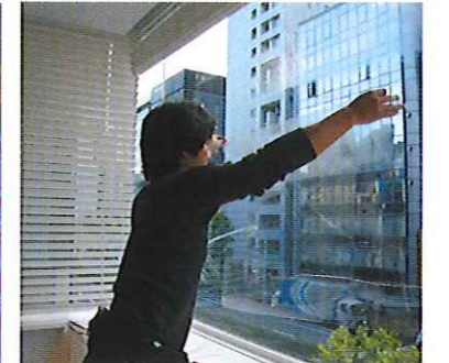
SC-74H施工風景 プロ業者により施工されます。
